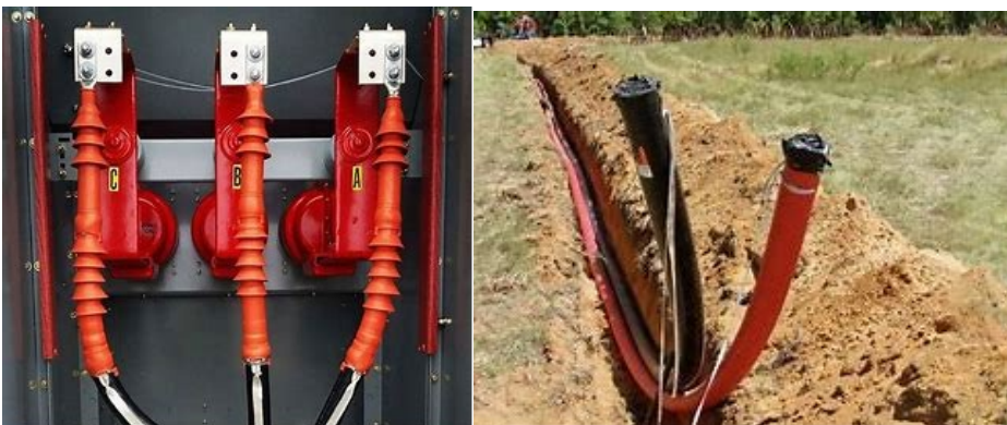
Eksempel på Kabel switch og kabeltrace med 2x10kV kabler
